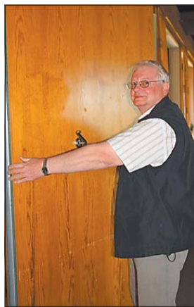
Wilhelm Brinker versucht, die alte Trennwand zu bewegen.
