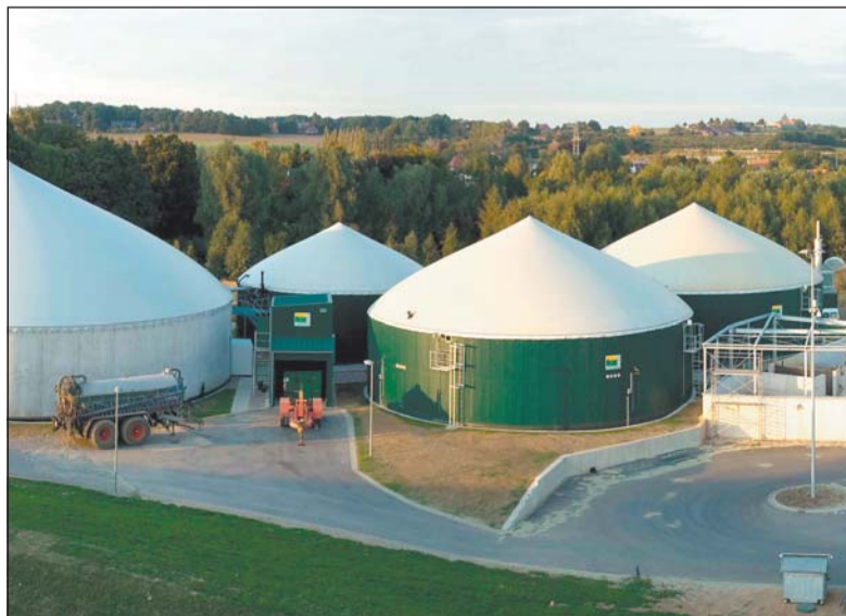
Mitglieder von Rat und Verwaltung haben sich die Biogasanlage in Kirchlegern angesehen. Die Anlage in Löhne wird jedoch keine Siloanlage und keine Waage haben.
