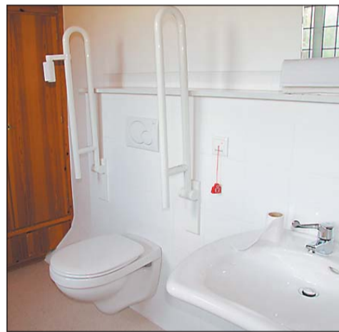
Eine behindertengerechte Toilette ist im hinteren Bereich der Kirche entstanden.
